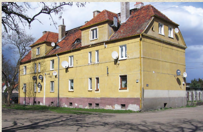
Widok na budynek przy ul. Ametystowej i Saskiej – stan na kwiecień 2015 r.
