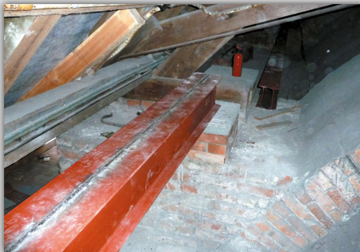
Belka stalowa na podporze
