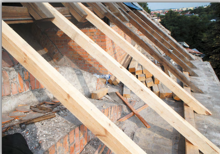
Wymienione krokwie dachowe
