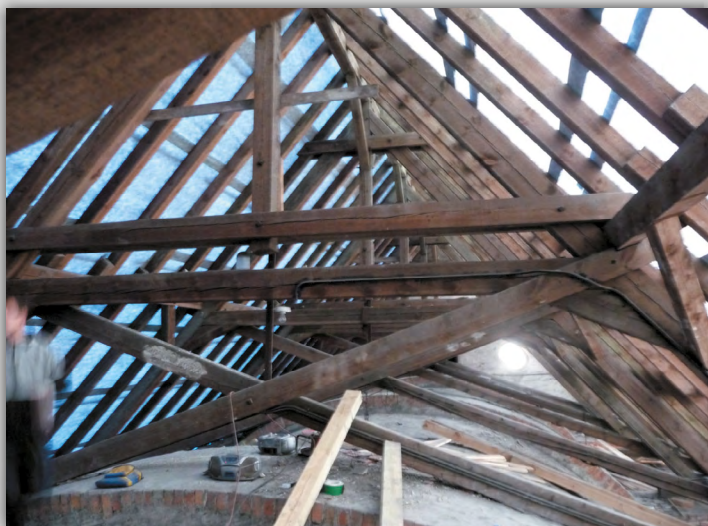
Konstrukcja dachu w trakcie impregnacji
