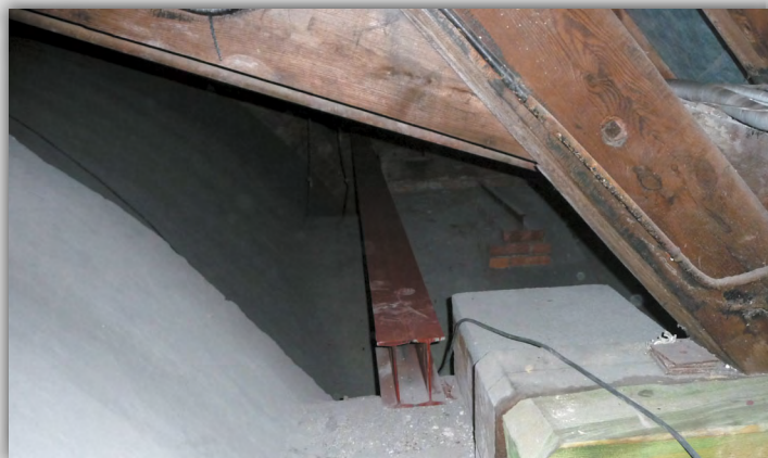
Przygotowana belka stalowa
