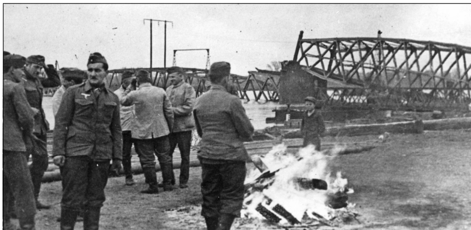
Zniszczony most fordoński
