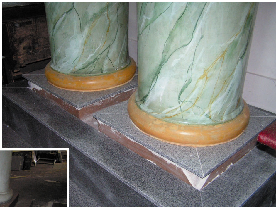
Remont cokółów. Obłożone zostały płytkami z granitu.
