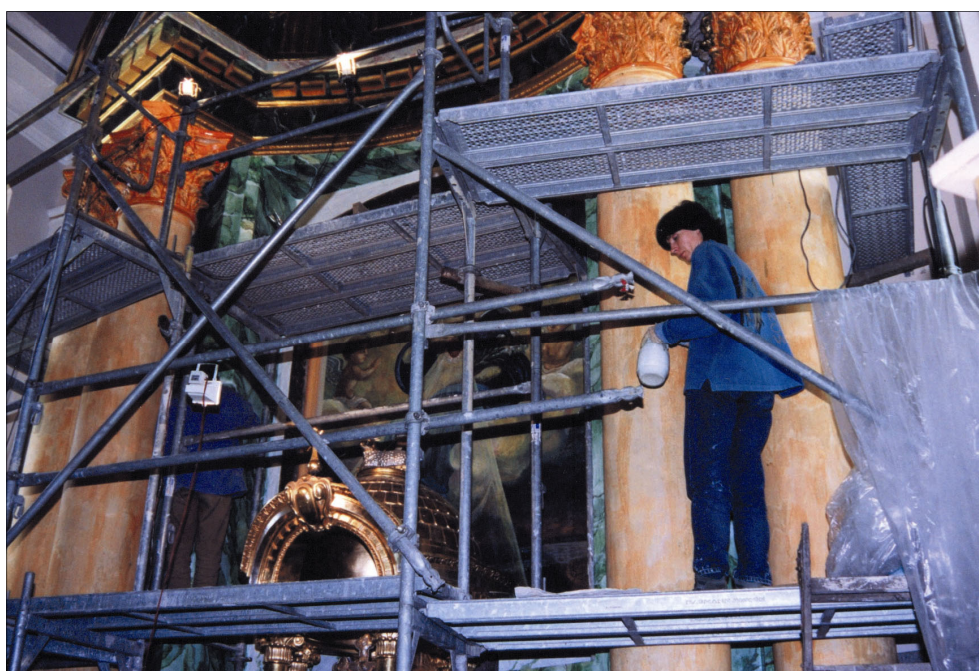
Ołtarz w trakcie renowacji.
