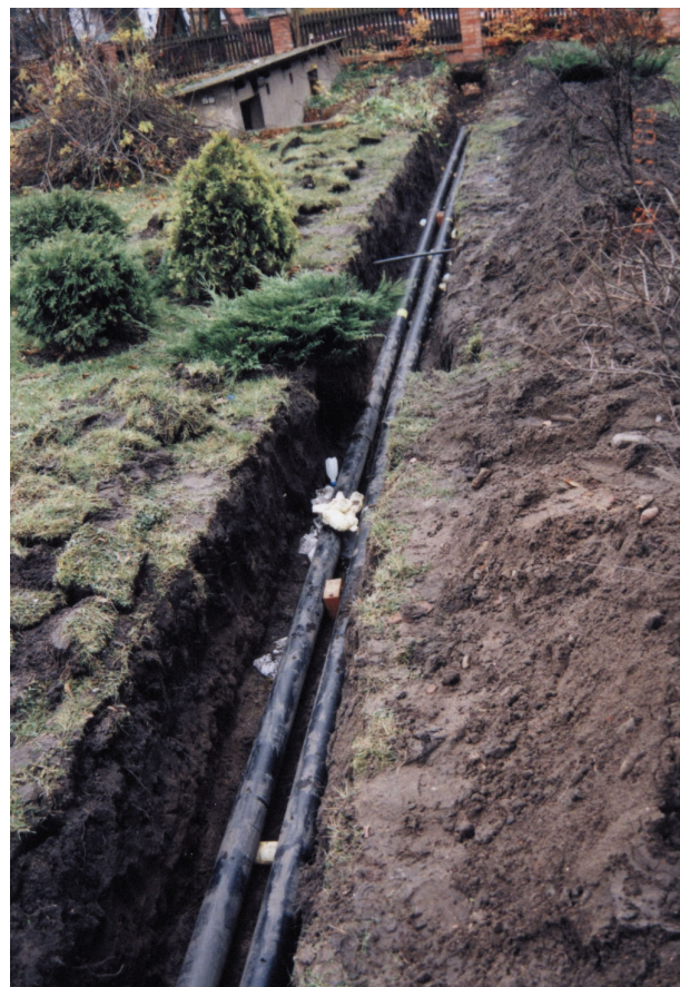
Wykopy, w których ułożone są rury łączące piec c.o. na plebani z instalacją grzewczą w kościele.
