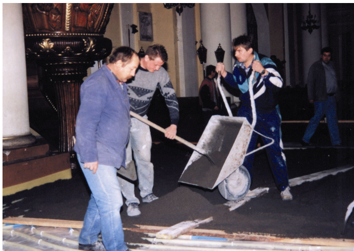
Całość pokryta betonem.
