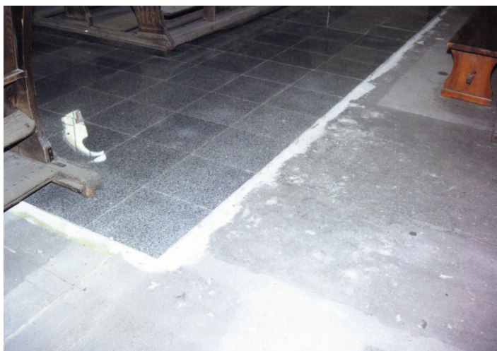
Układanie posadzki granitowej.
