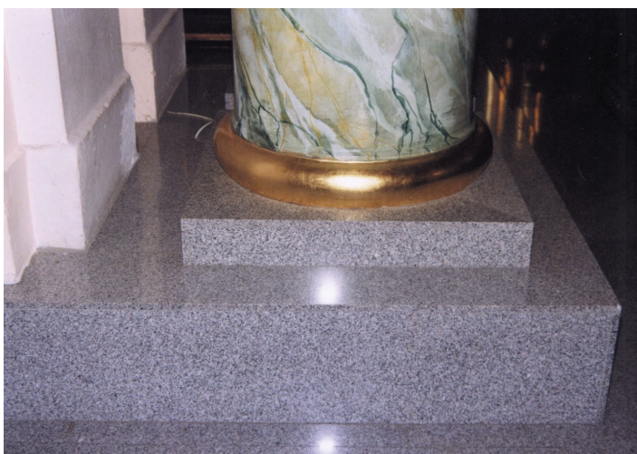
Cokoły filarów po obłożeniu granitem.
