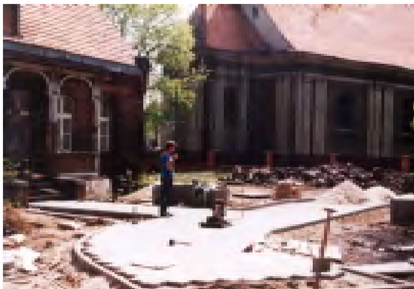
Kładzenie „polbruku” na podjazd przed plebanią. Kamień widoczny na zdjęciu zostanie wykorzystany na wyłożenie miejsc parkingowych.
