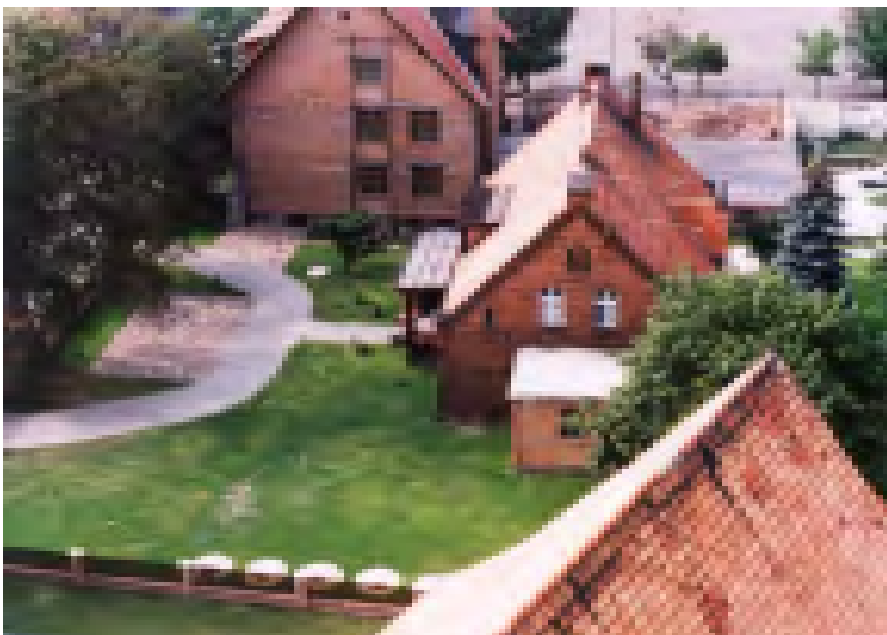
Po ukończeniu prac porządkowych. Teren wyrównany. Trawa zasiana. Podjazd wykonany z „polbruku”. Dwa miejsca parkingowe wyłożone kamieniem.
