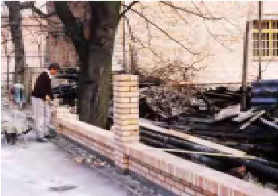
Wykonywanie ogrodzenia. Teren jeszcze nie uporządkowany.
