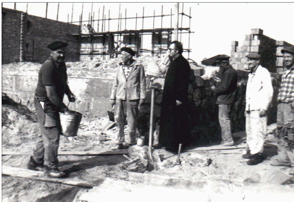
Na placu budowy kościoła w Strzelcach Górnych. Ks. Prob. Stanisław Grunt z pracownikami parafialnymi.
