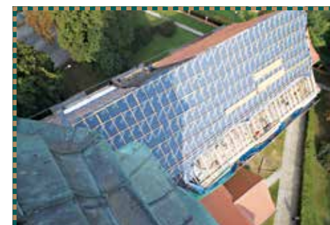
Wymiana krokwi, zakładanie specjalnej folii i nowych dachówek.
