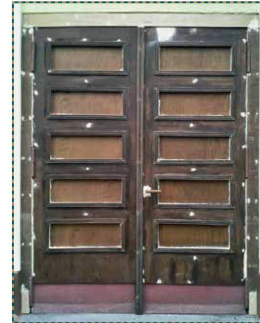
Nieżywane drzwi od strony ul. Wyzwolenia w trakcie remontu.
