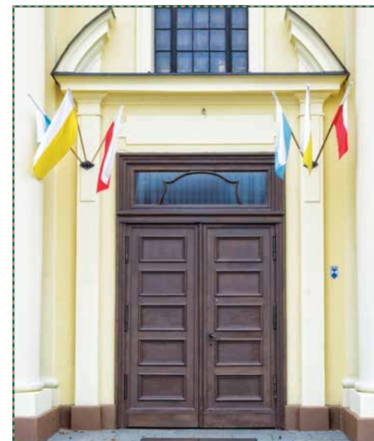
Stan po remoncie.
