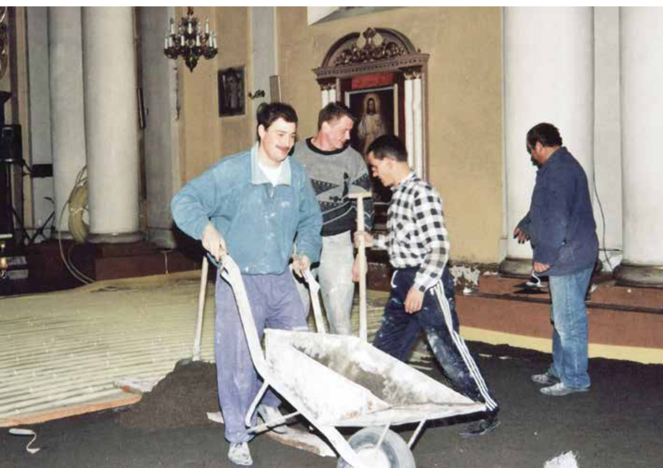
Zakładanie ogrzewania podłogowego.
